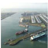
Page 50-3 Global LNG Photo: Gate terminal (Netherlands)
